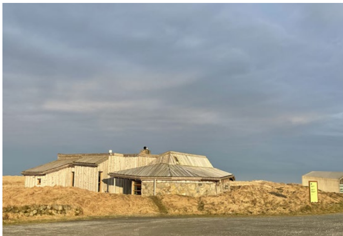
Friluftshuset på Orre og Besøkssenter Våtmark Jæren.
