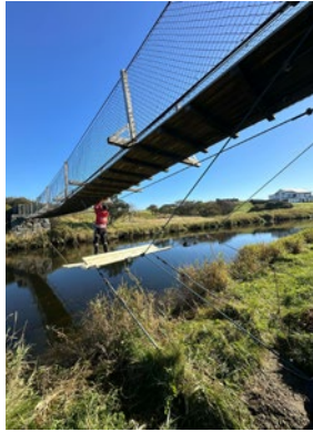
Oppgradering av Figgjobroa.
